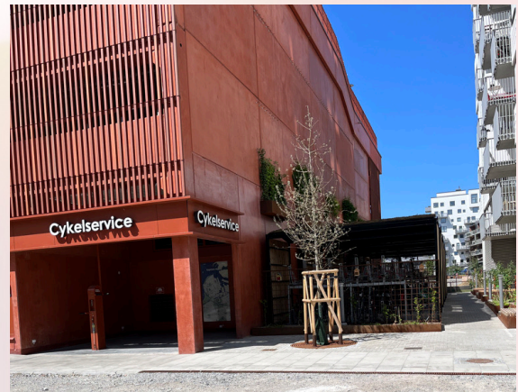
Mob-hus i Västra hamnen, Malmö.
